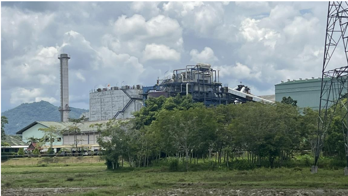
ภาพที่ ข.6 โรงไฟฟ้าชีวมวล
